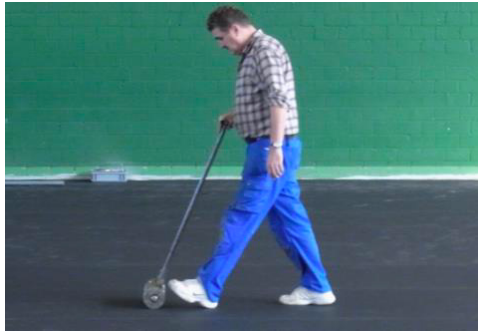
Abrollen des Belages mit einer Anpresswalze.
