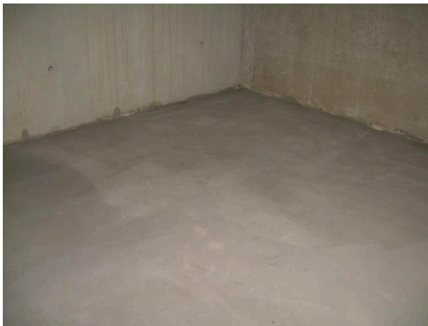
Glatter, geeigneter Untergrund aus Betonestrich.
