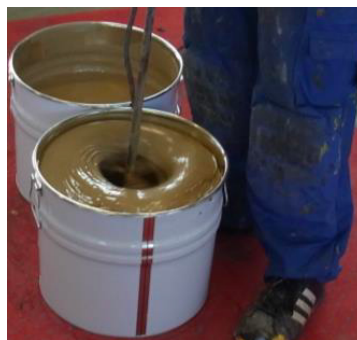
Anrühren des 2-Komponenten-PU-Klebers.
